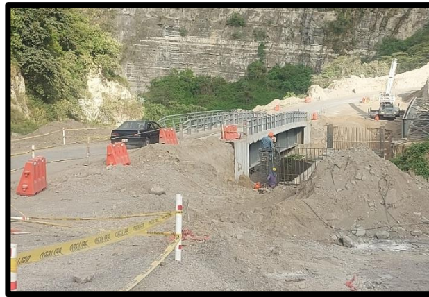
Figura 6. Puente Calle Abdón Calderón
