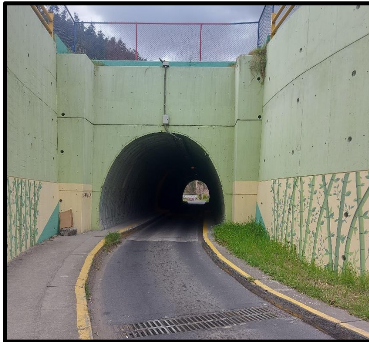
Figura 5. Túnel Entrada a Nayón
