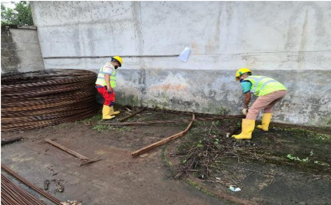
Foto 35 Armado de Varillas. Levantamiento manual de cargas
