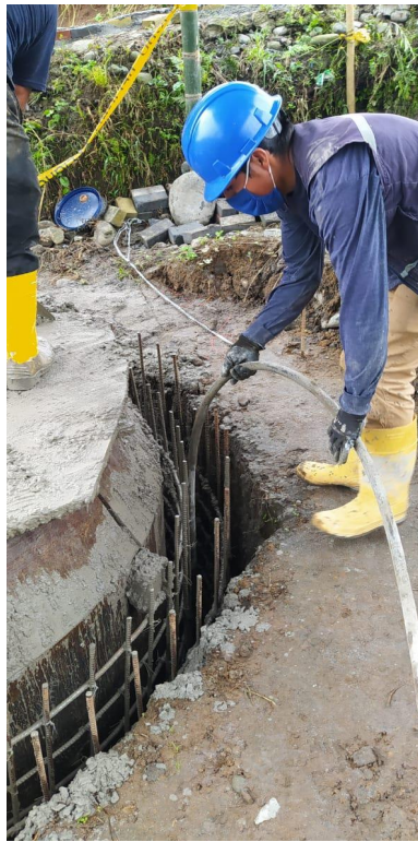
Foto 16 Vibración del hormigón.
