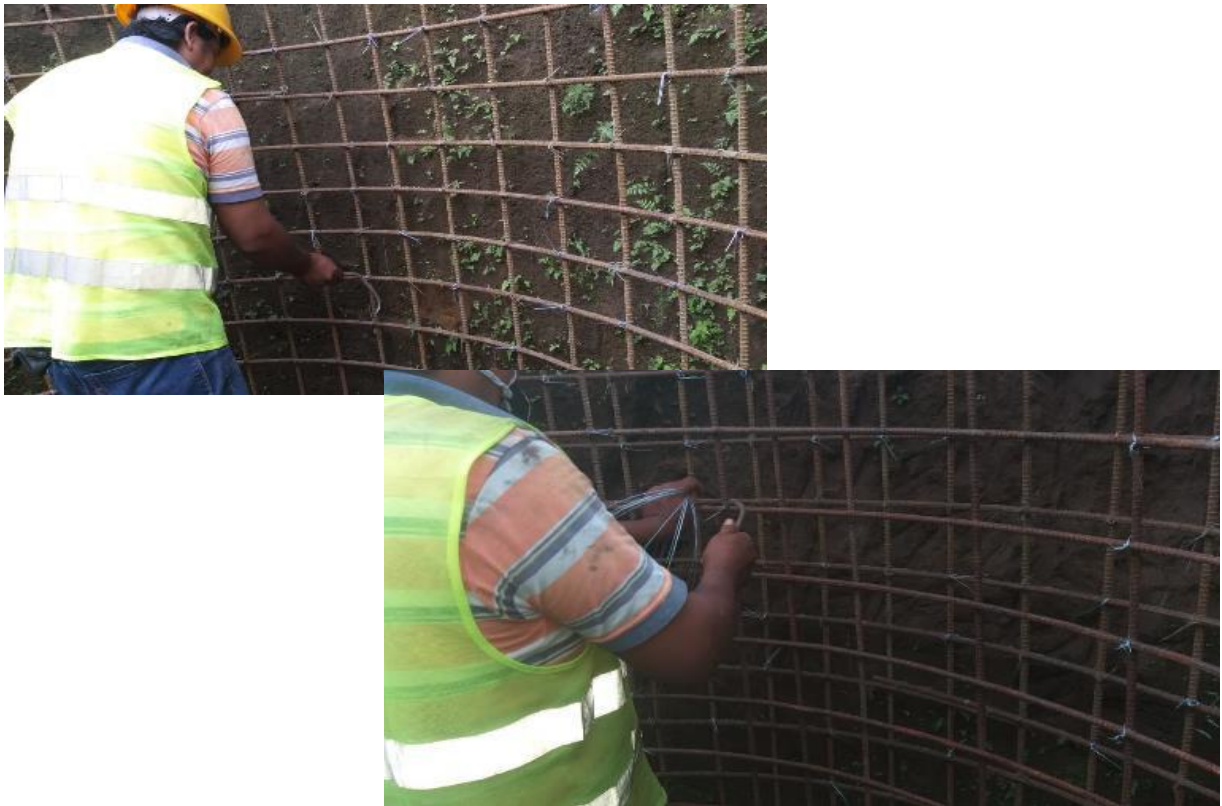
Foto 14 Armado de varillas en pozos
