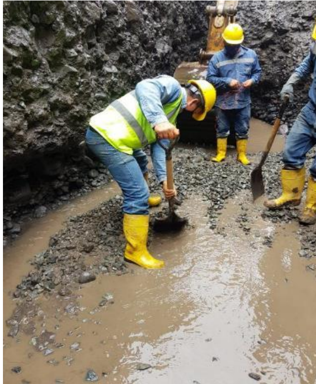
Foto 2 Actividad excavación y relleno de zanja
