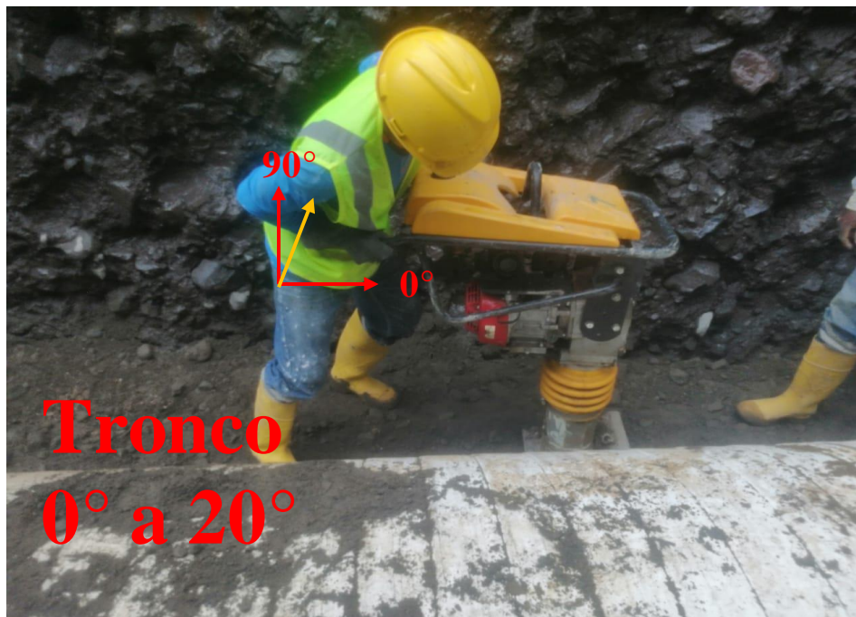
Foto 28 Compactación del material medición de ángulos RULA
