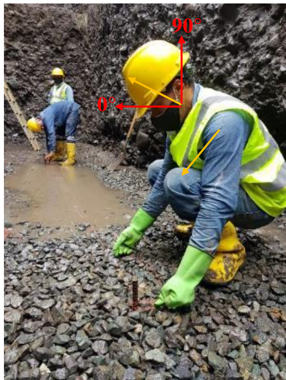
Foto 19 Alineación de tubería medición de ángulo REBA
