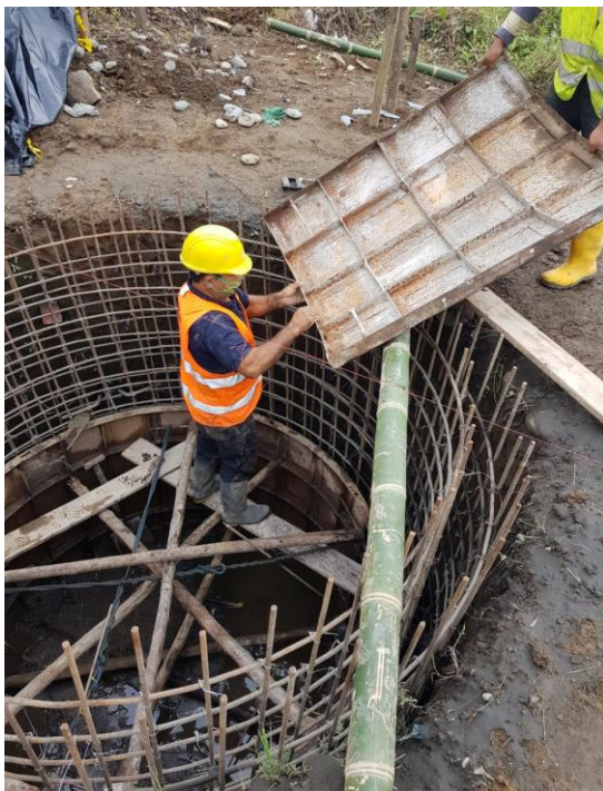
Foto 34 Encofrado de pozos. Levantamiento manual de cargas
