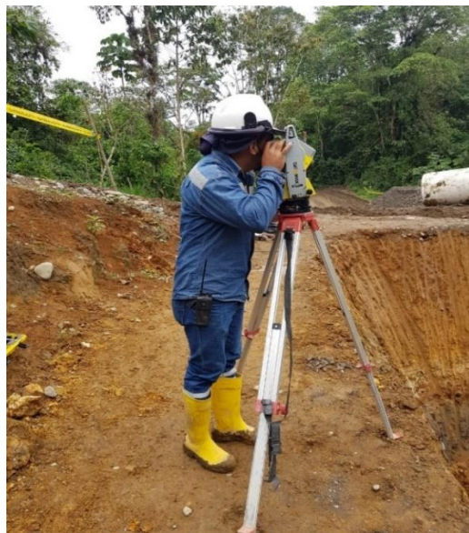
Foto 4 Alineación de tubería con estación total Lugar y fecha: Obra alcantarillado Zona B Santo Domingo. Agosto 2020.
