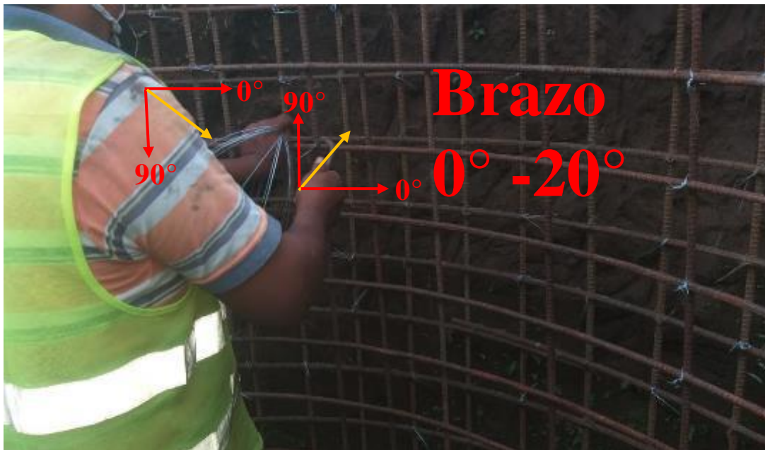
Foto 22 Armado de varillas medición de ángulos REBA
