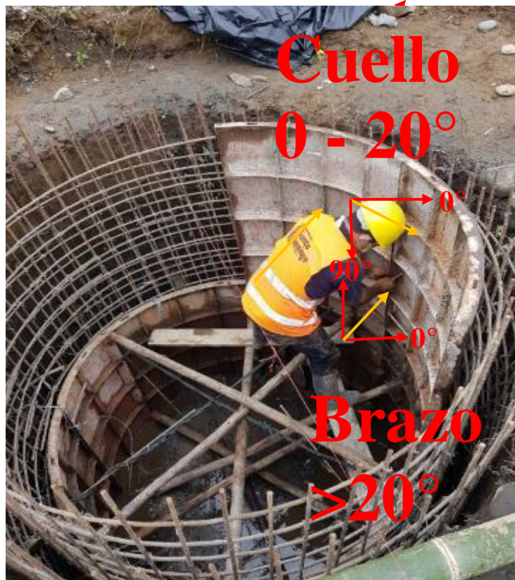
Foto 21 Encofrado de pozos medición de ángulos REBA
