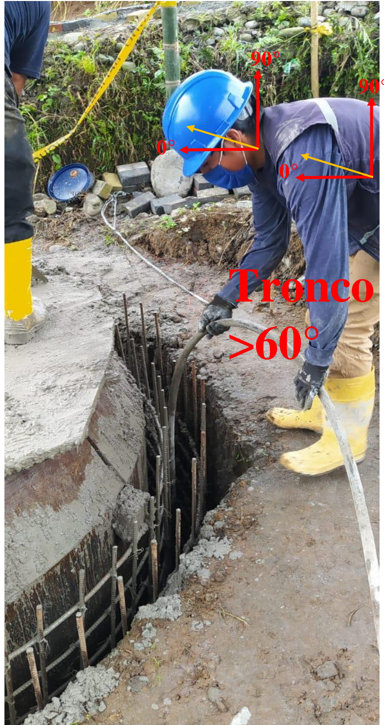
Foto 32 Vibración del hormigón RULA
