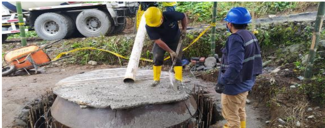
Foto 15 Vertido del hormigón con pala
