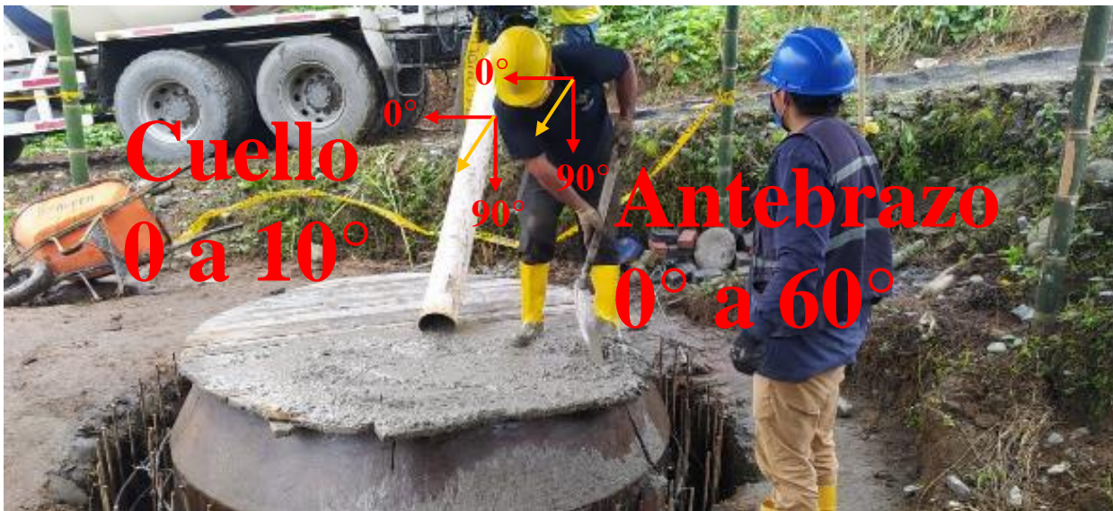
Foto 31 7. Vertido del hormigón con pala medición de ángulo RULA Lugar y fecha: Obra alcantarillado Zona B Santo Domingo. Agosto 2020.
