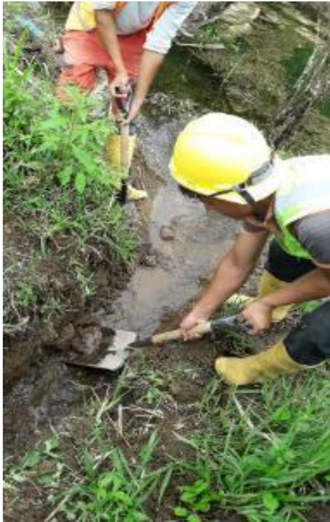
Foto 9 Excavación y relleno manual método OCRA
