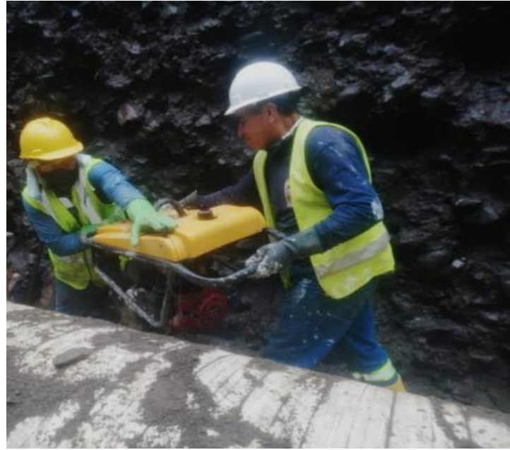
Foto 12 Compactación del material en zanja
