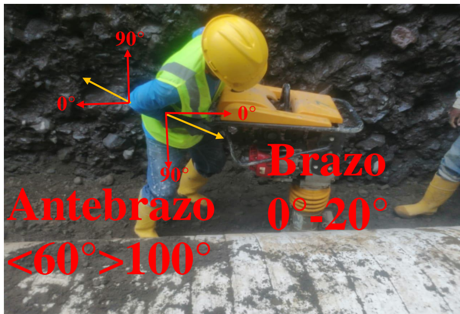
Foto 20 Compactación del material REBA
