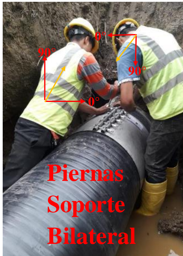
Foto 18 Instalación de tuberías medición de ángulos REBA
