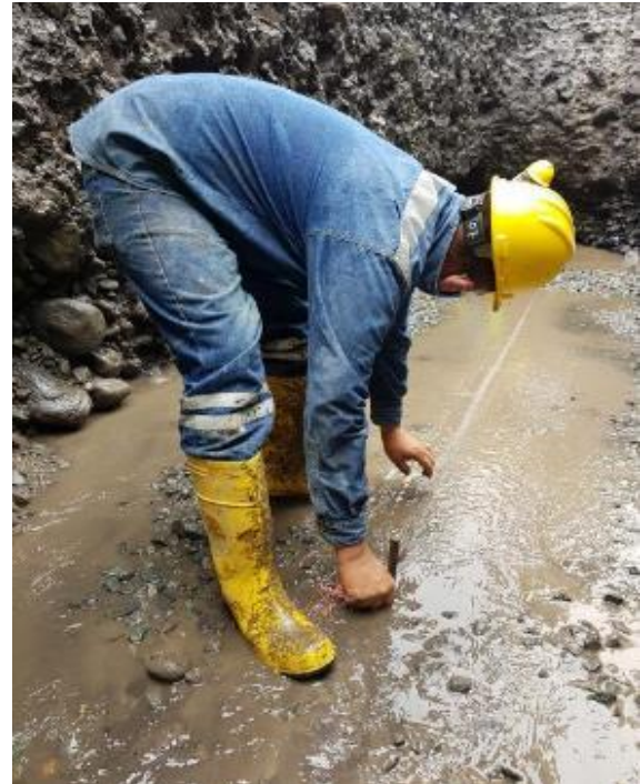
Foto 11 Alineación de tubería de PVC
