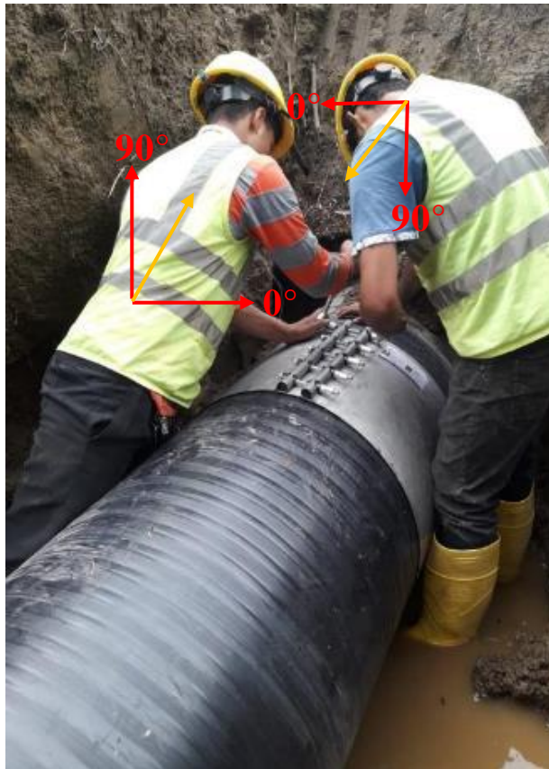
Foto 26 Instalación de tubería medición de ángulos RULA
