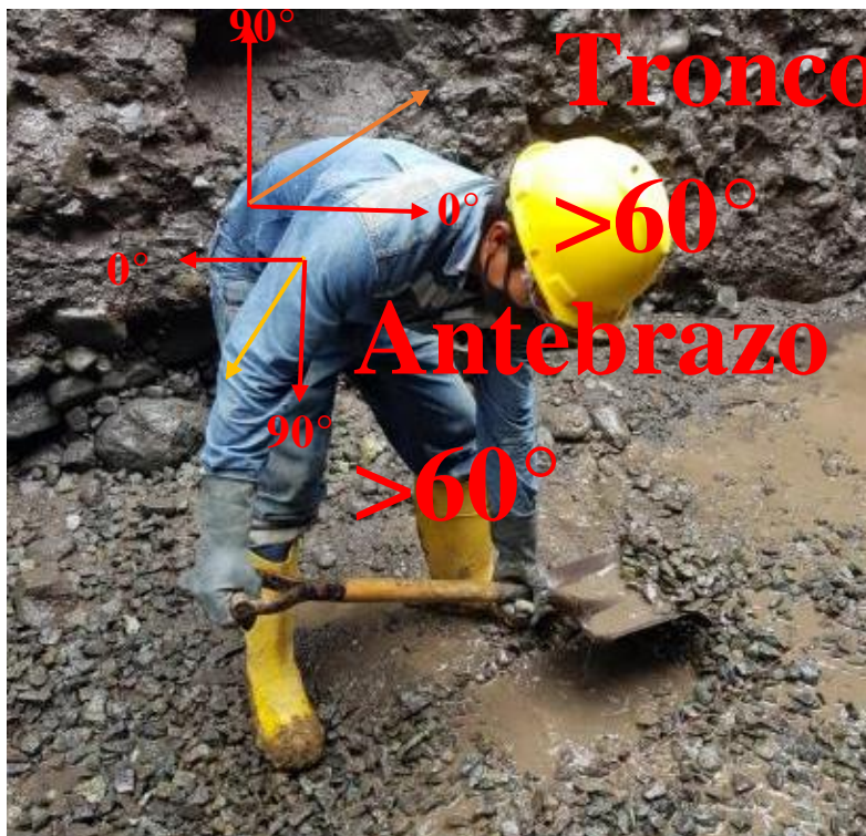
Foto 17 Excavación y relleno manual método REBA
