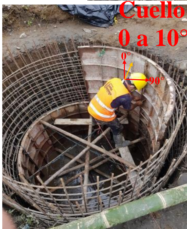
Foto 29 Encofrado de pozos medición de ángulos método RULA
