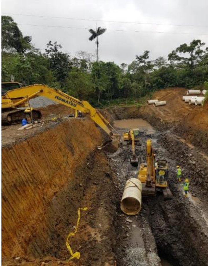
Foto 1 Caso de estudio Vista Zanja en ejecución
