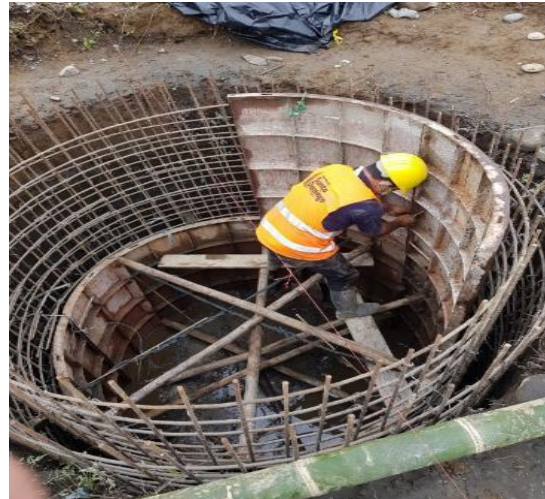
Foto 13 Encofrado de pozos
