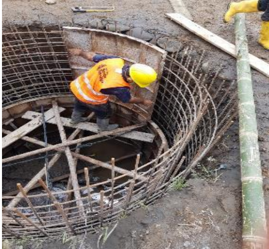
Foto 13 Encofrado de pozos
