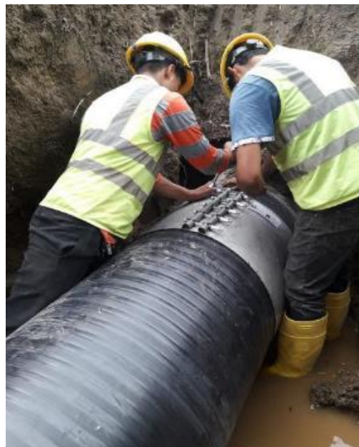
Foto 3 Actividad instalación de tuberías
