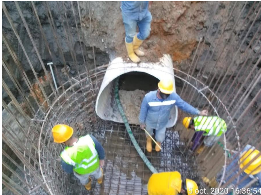
Foto 7 Actividad de encofrado de pozos
