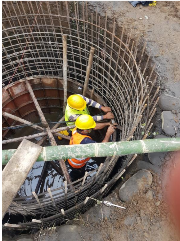
Foto 6 Actividad de encofrado de pozos
