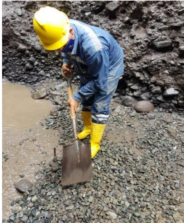
Foto 9 Excavación y relleno manual método OCRA
