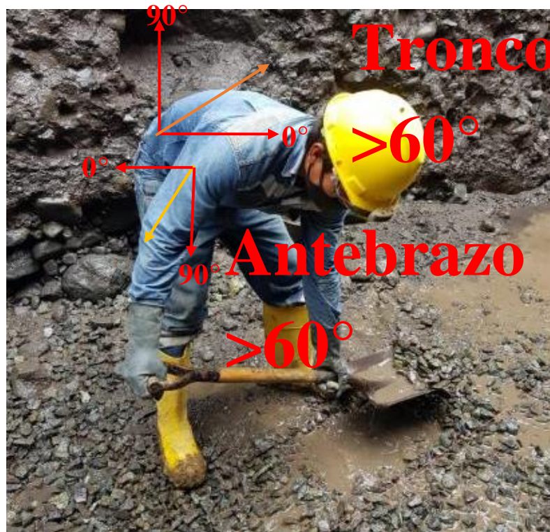
Foto 25 Excavación y relleno manual zanjas medición de ángulos RULA Lugar y fecha: Obra alcantarillado Zona B Santo Domingo. Agosto 2020.
