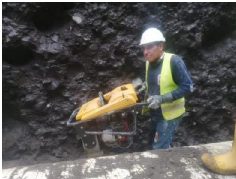
Foto 5 Actividad de compactación de relleno en zanja
