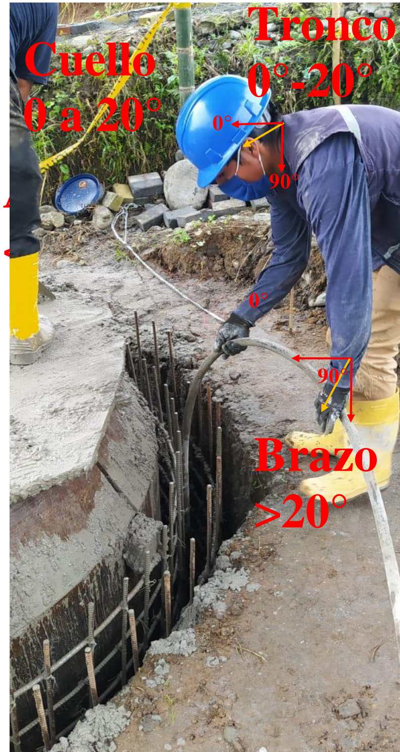
Foto 24 Vibración del hormigón REBA
