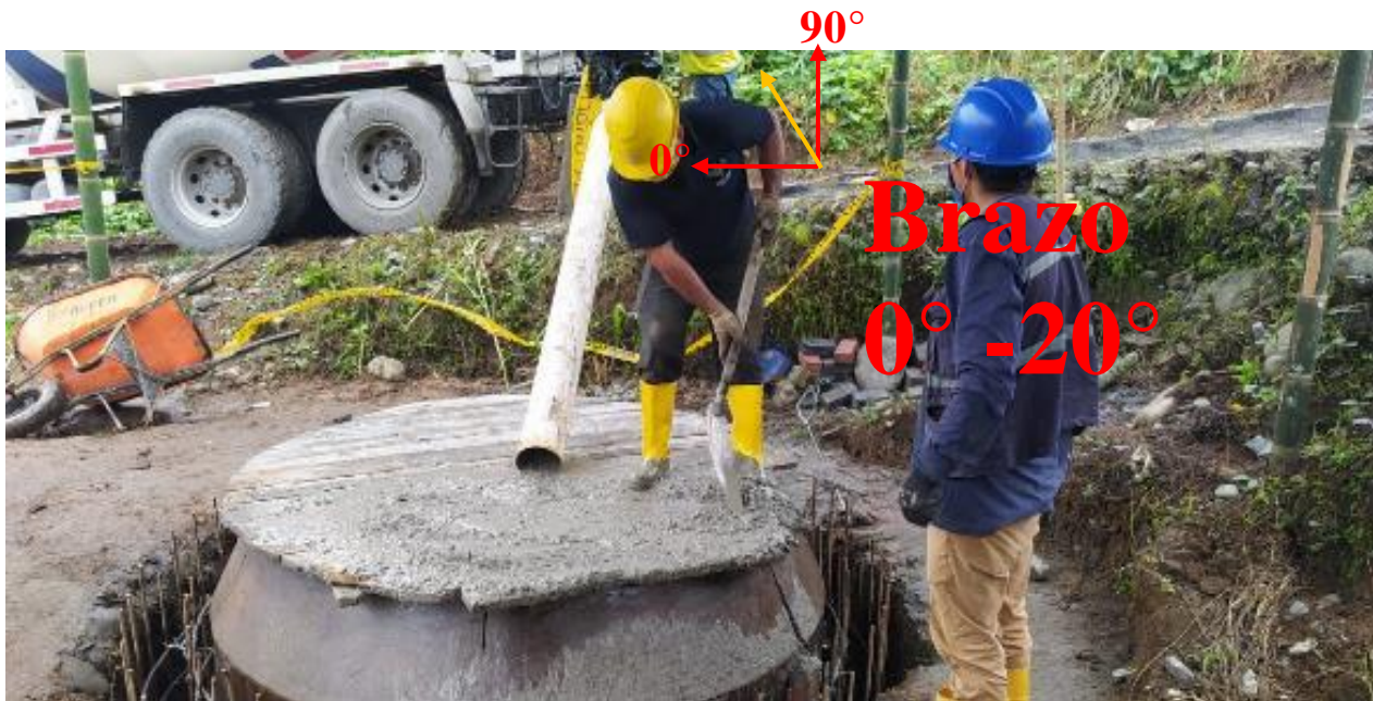
Foto 23 Vertido del hormigón con pala medición de ángulos REBA
