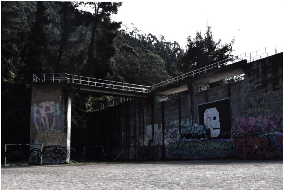
Figura 48: Dique del sector de Rumipamba
