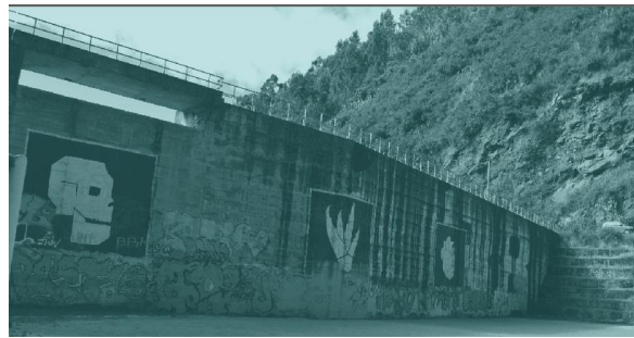
Figura 27: Represa ubicada en Rumipamba
