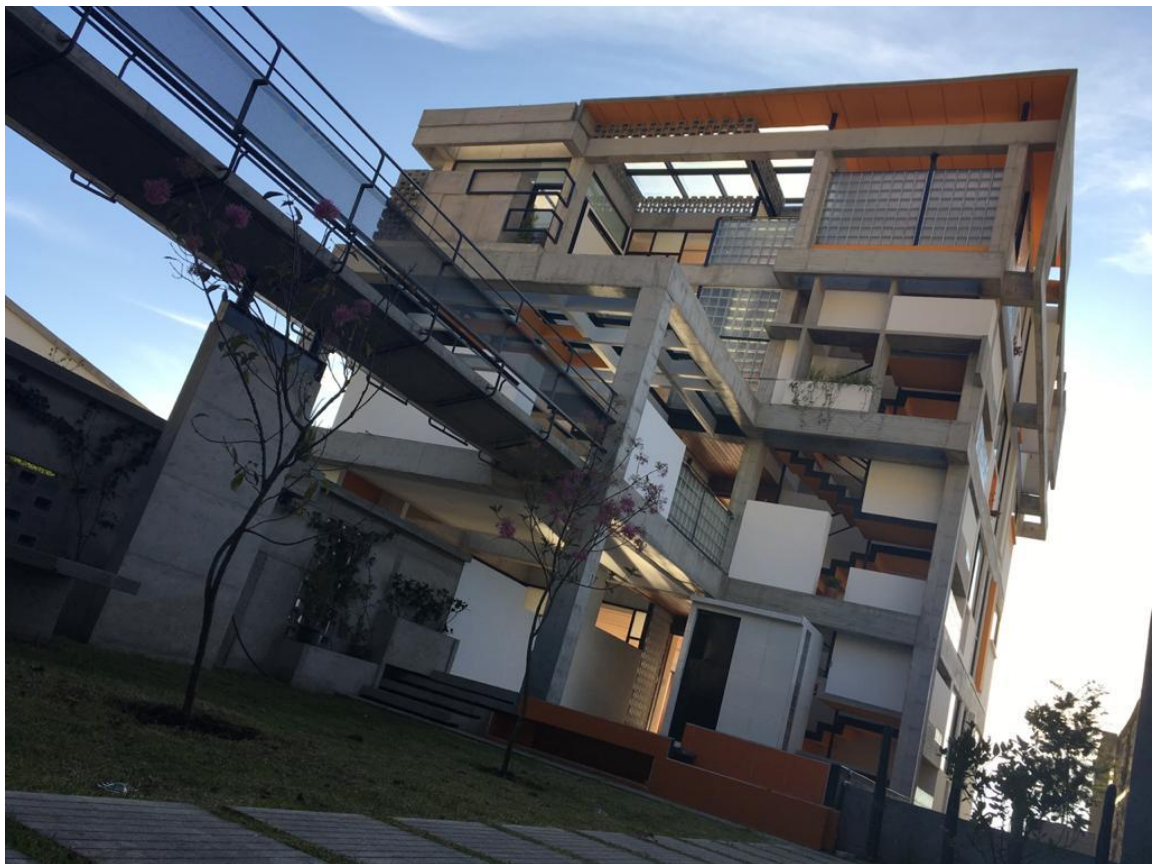
Figura 32: Fotografía puente peatonal de ingreso
