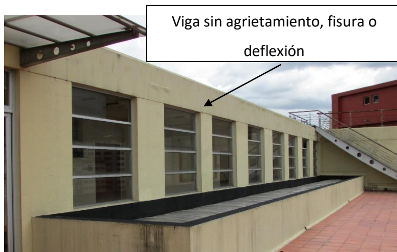
Ilustración 20: Viga exterior de losa de cubierta. Capturado y modificado por Francisco Redín, 2017
