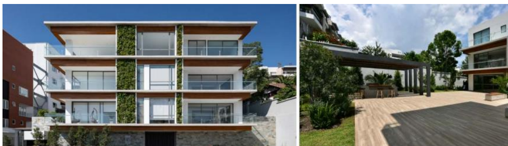
Ilustración 2.3 Edificio Denali con certificación EDGE
