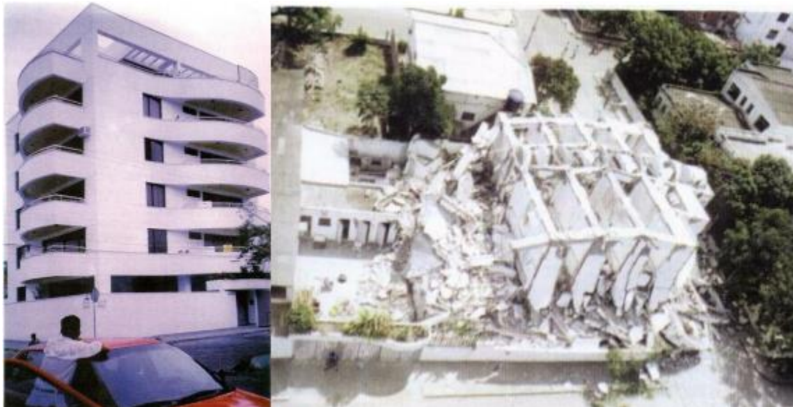
Figura 2 Edificio Calipso Antes/ Después del sismo de 1998. Fuente: USGS
