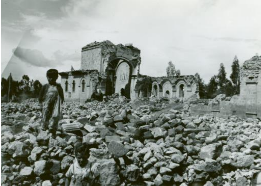
Figura 1 Ruinas de la Iglesia Santa Rosa sismo de 1949, Tungurahua. Fuente: USGS
