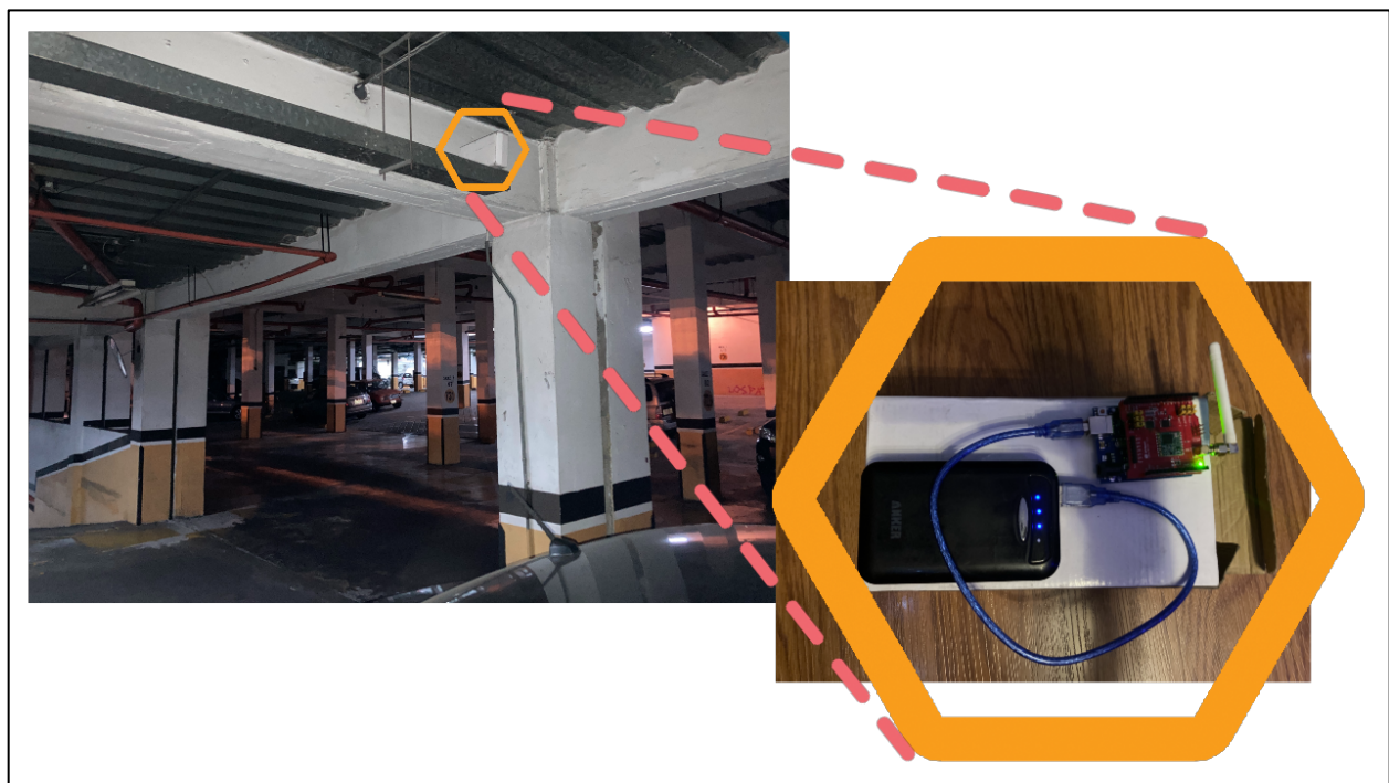
Figura 4 – 01 Lugar No. 1 para la instalación provisional del módulo LoRa shield en el subsuelo 1 del CHPR para pruebas de RSSI al interior de los parqueaderos de visita del CHPR (Mejía, 2020).
