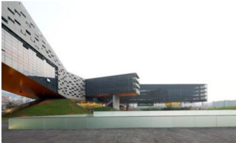
Imagen 43: Rascacielo Horizontal - Vanke Center. Fuente: Fotografía Shu He, Steven Holl Architects
