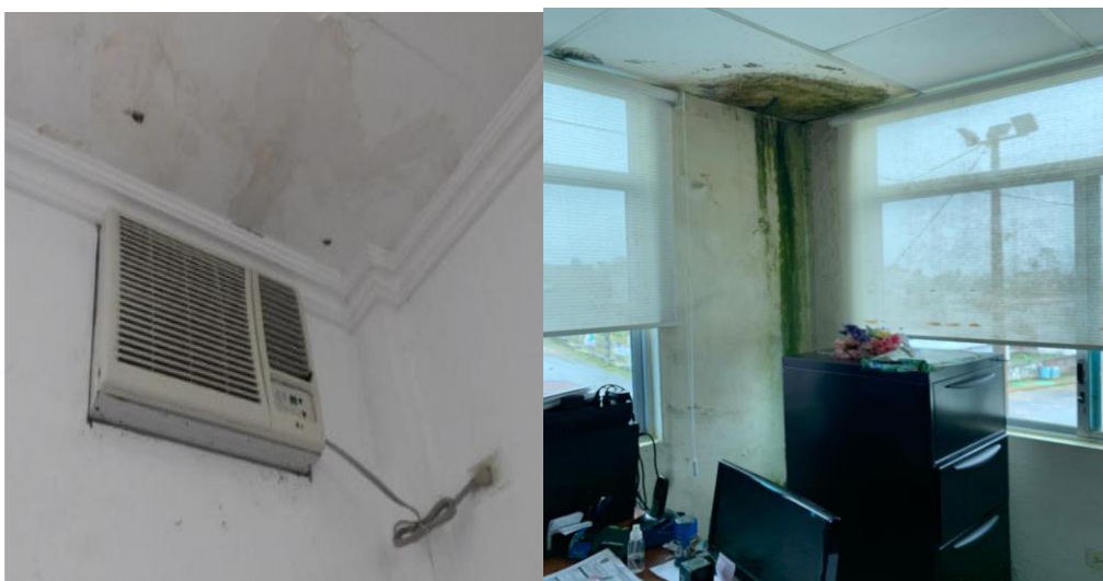
Figura 6. Presencia de hongos. (Foto del Autor, 10 de julio, 2020, con autorización Dirección GAD)
