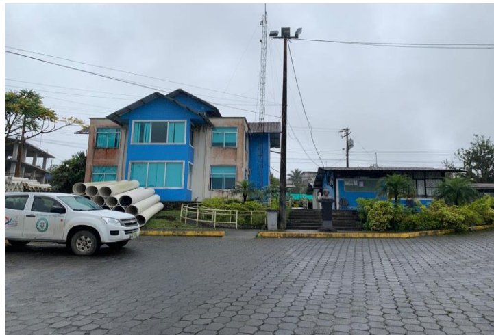
Figura 3. Materiales en condiciones inadecuadas.
