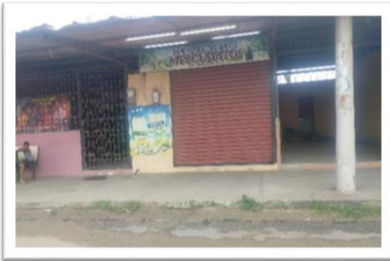
Foto 7 Espacio del fondo – Parqueadero de buses
