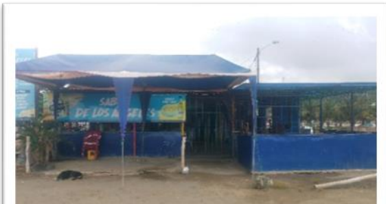
Foto 3 Parqueadero de buses
