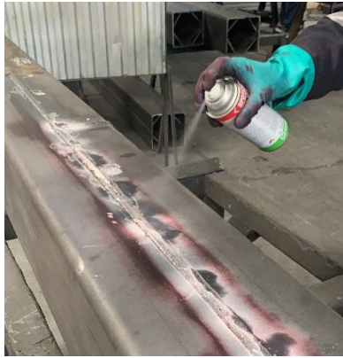
Ilustración 21: Aplicación de Revelador en superficie de ensayo.
