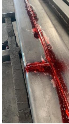
Ilustración 15: Aplicación de Tinta penetrante en superficie de ensayo.
