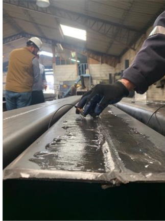
Ilustración 27: Barrido de ensayo de ultrasonido.
