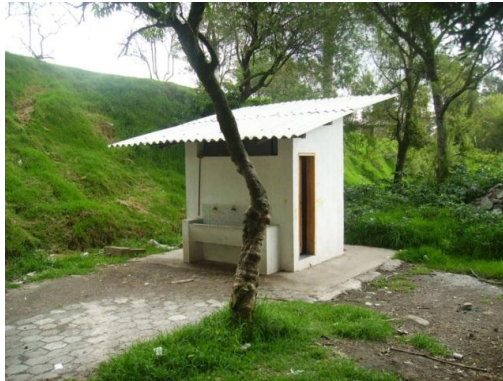
Fotografía No. 17 Baterías Sanitarias Parque Santa Clara – Sangolquí. Fuente: Puebla Glenda, julio 2013
