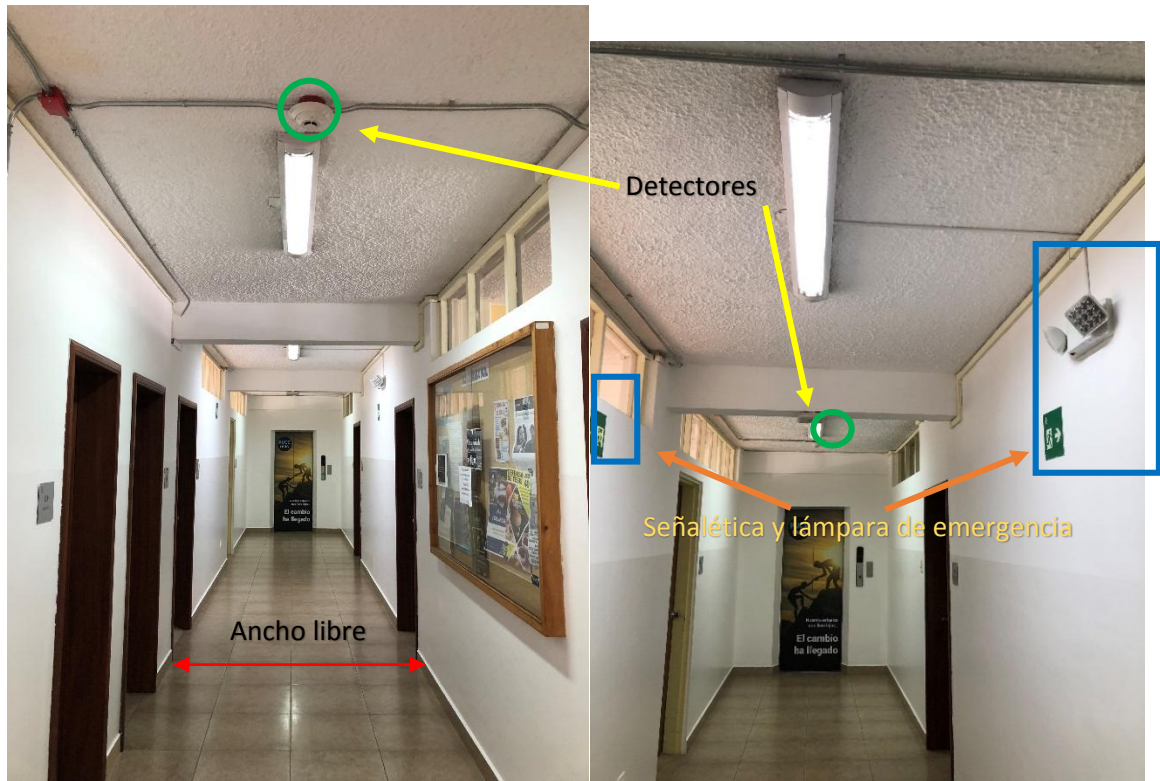
Pasillo ascensor planta baja
