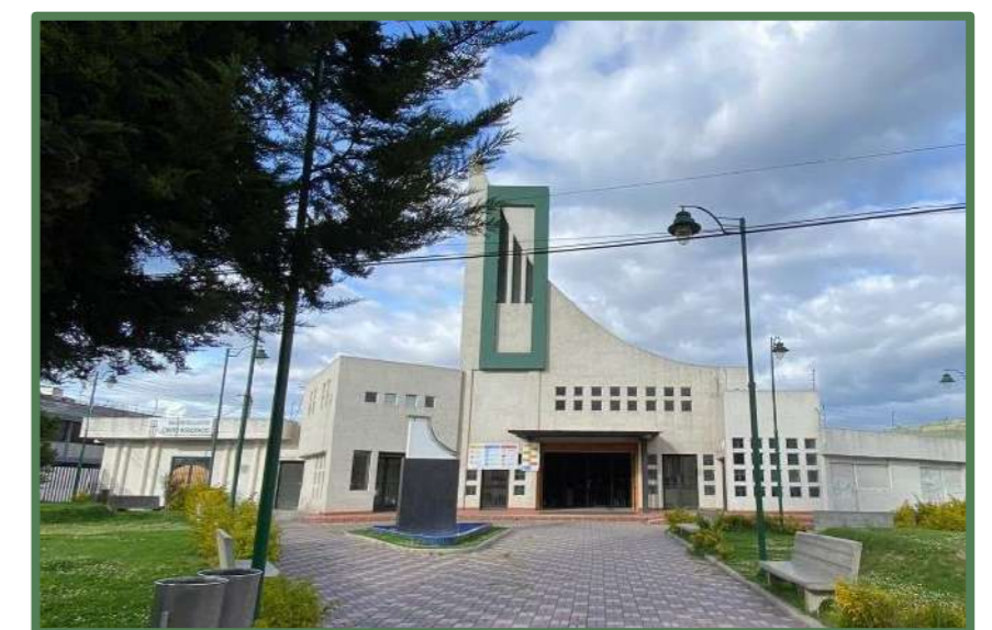
Figura 53: Vista frontal, Iglesia y sala de velaciones "Cristo Resucitado". Elaboración propia (2022)
