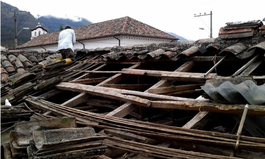
Fig. 20 Primer día trabajo, reparación del techo. Archivo personal, 2016.
