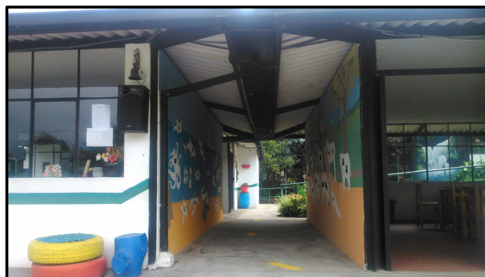
Ilustración 48. Pasillo entre el Aula 1 y 2 FINE (Autores, 2014)
