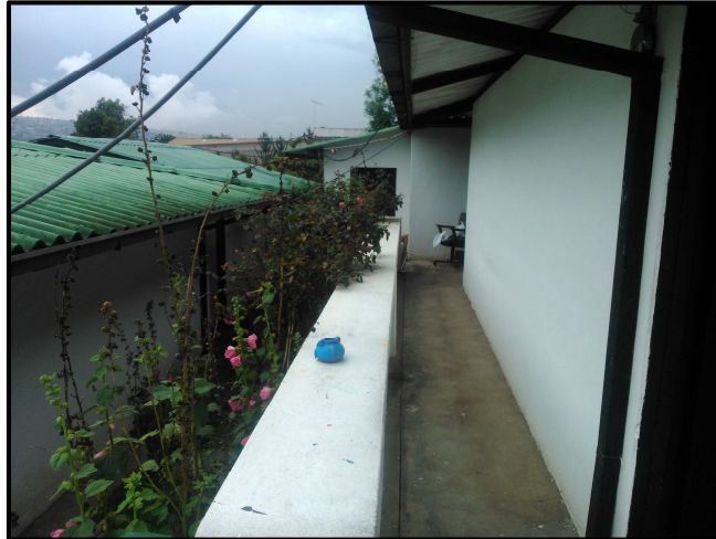
Ilustración 49. Pasillo entre el Aula 2 y 3 FINE (Autores, 2014)
