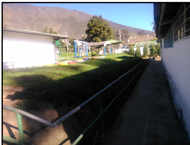
Ilustración 51. Pasillo entre el Aula 3 y Panadería FINE (Autores, 2014)
