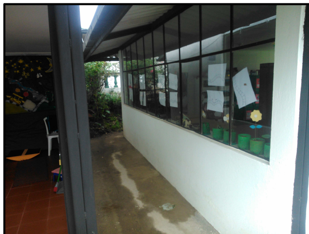
Ilustración 50. Pasillo entre el Aula 3 y 4 FINE (Autores, 2014)
