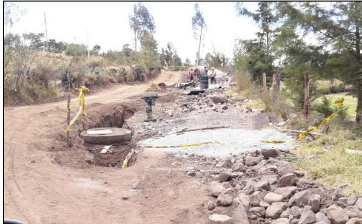
Foto No.4. Construcción de alcantarillado
