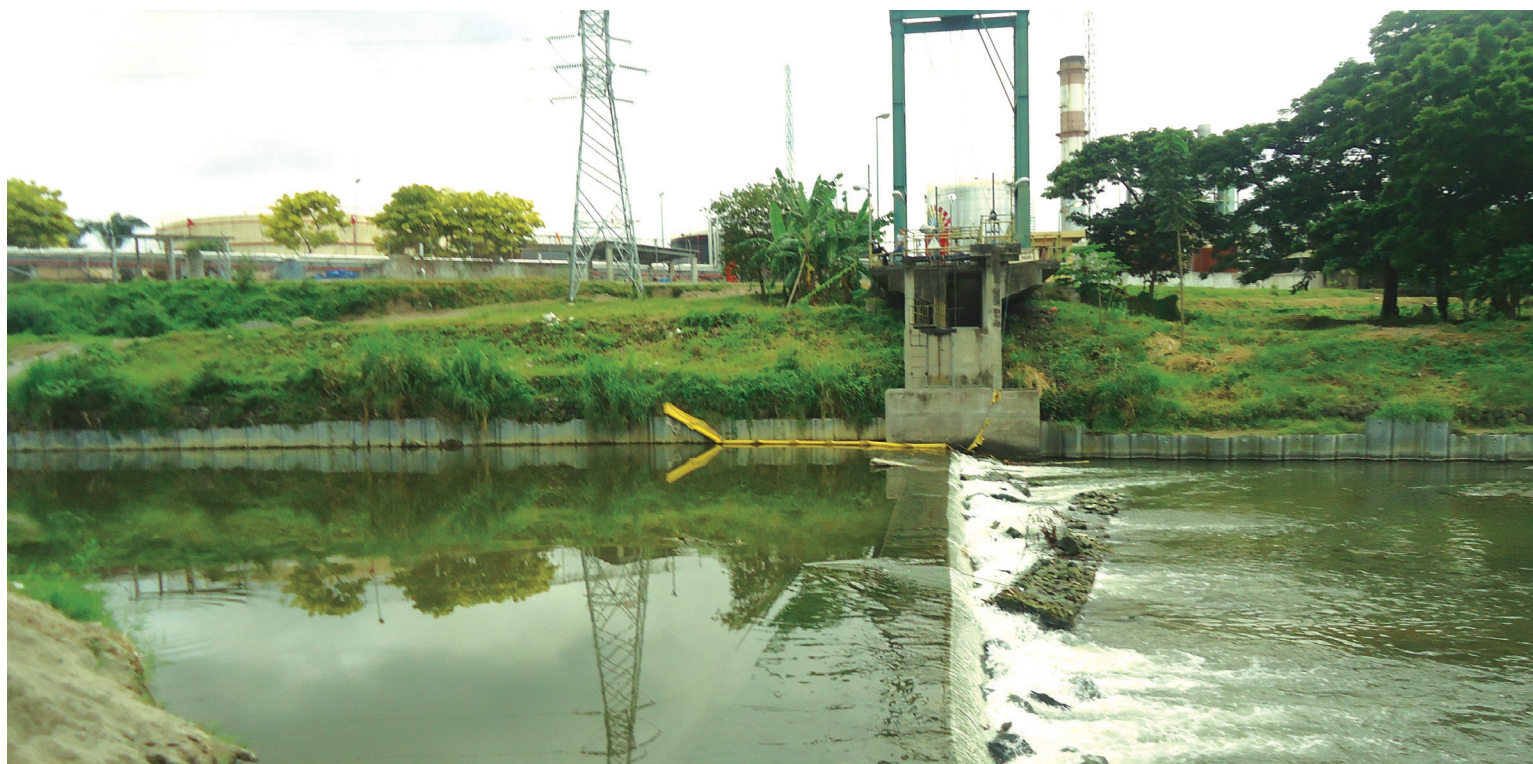
Foto 1. Río Teaone Sector Termoesmeraldas. Fuente: Autores
