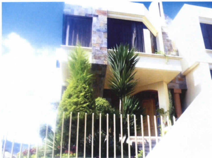
Imagen N° 78. Vivienda Unifamiliar Ambato - Junio 15, 2009
