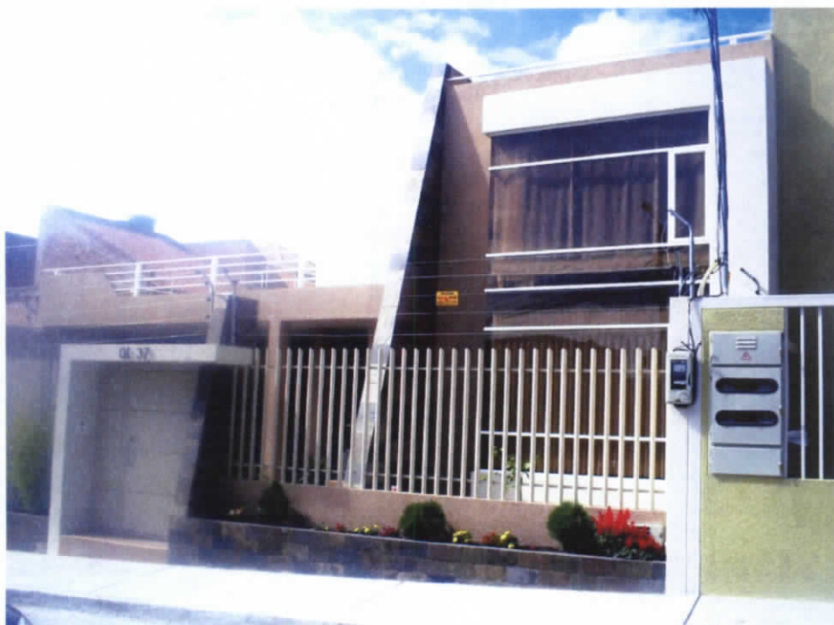
Imagen N° 76. Vivienda Unifamiliar Ambato - Junio 15, 2009
