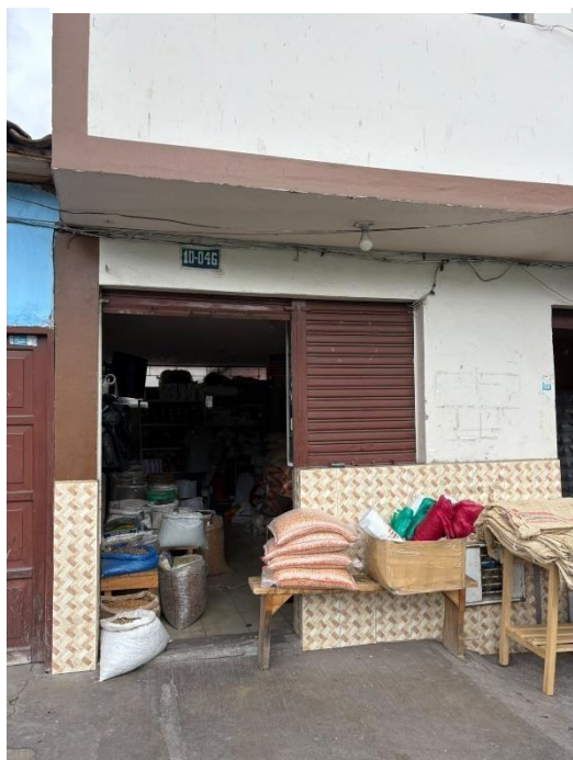
Figura 1: Fachada de la bodega de granos
