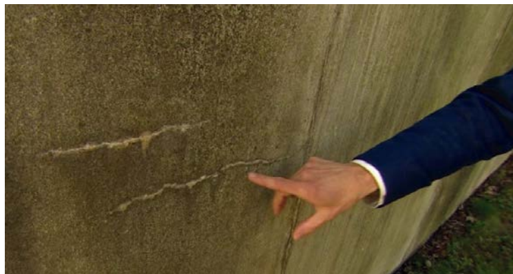
Auto reparación de bio concreto
