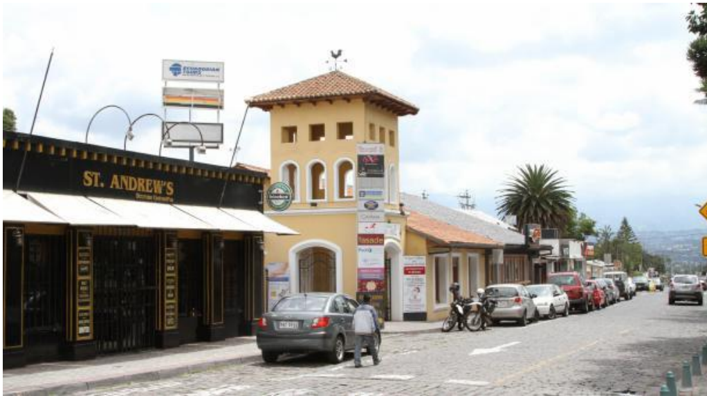
Foto 1. Locales comerciales alrededor del parque central en la parroquia Cumbayá
