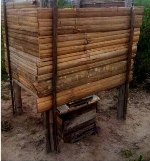
Comuna Rhiannon. Baños ecológicos y letrinas composteras. Fuente: Archivo fotográfico privado CD.
