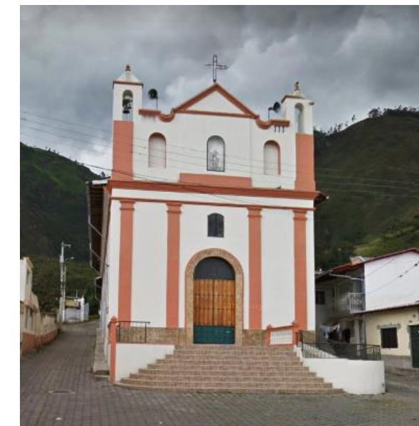
Figura 24: Iglesia de Yahuarcocha Fuente: Nadia Acosta, 2015
