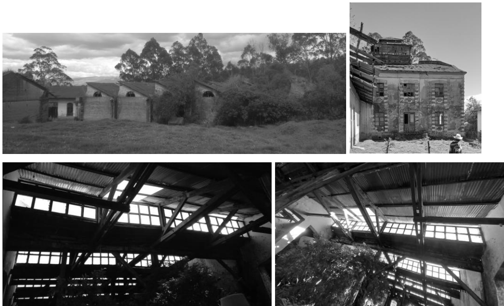
Figura 6.- Elementos que se conservan en la ex fábrica “La Inca”
