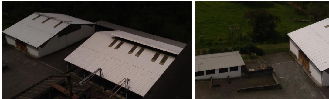
Figura 5.- Elementos que se eliminan de la ex fábrica del Trópico
