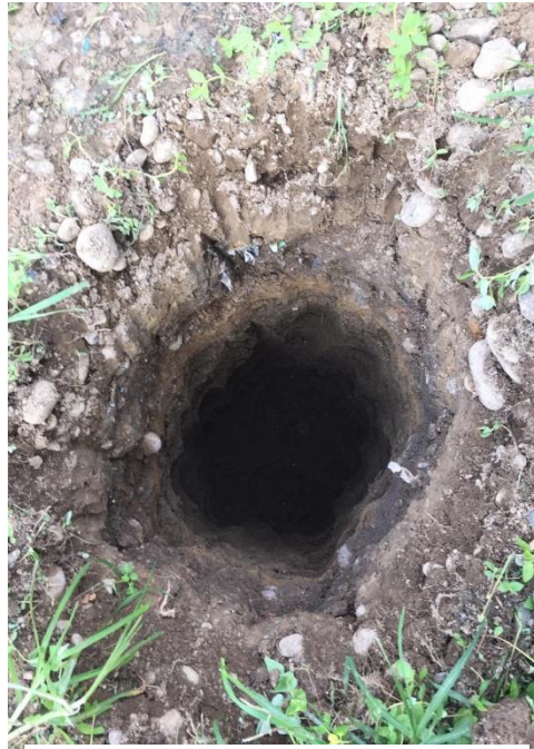
Excavación de hoyo realizado
