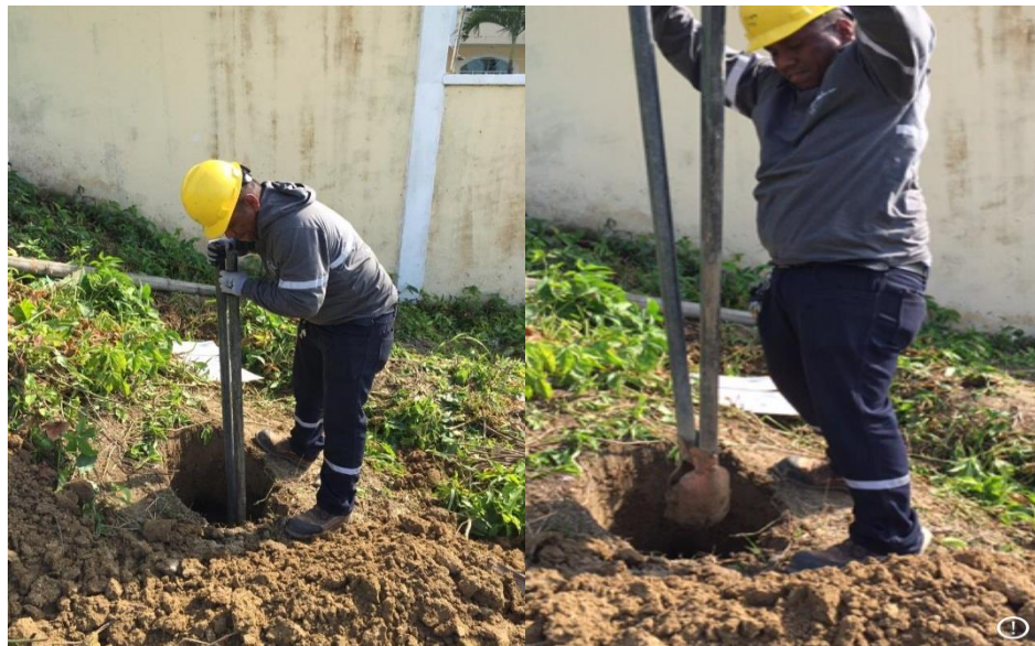
Figura 26. Levantamiento manual de carga-1 Fuente: Grupo excavadores de hoyos CNEL Unidad de Negocio Esmeraldas
