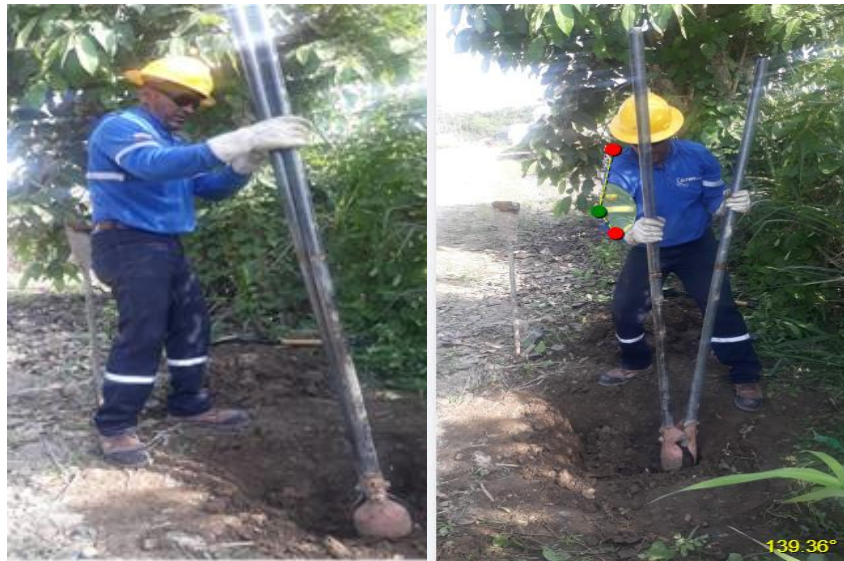
Figura 28. Movimientos repetitivos de los excavadores de hoyos-1 Fuente: Grupo excavadores de hoyos CNEL Unidad de Negocio Esmeraldas
