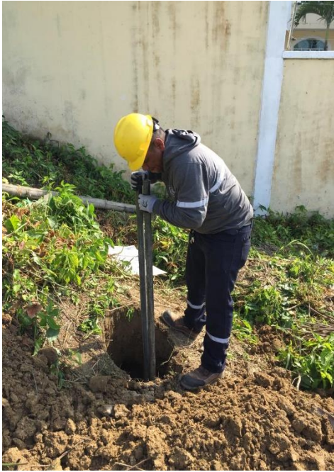
Inicio de excavación de hoyos
