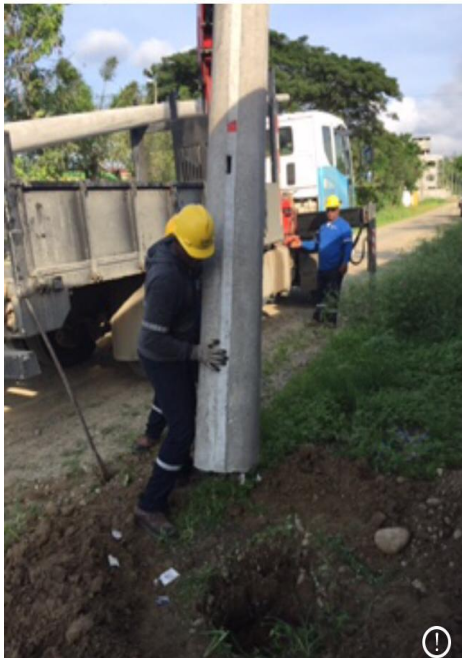
Inicio de izado postes
