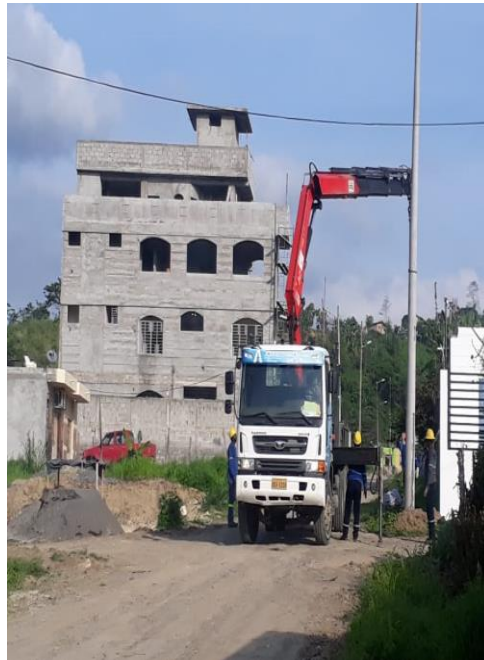
Izado final de postes
