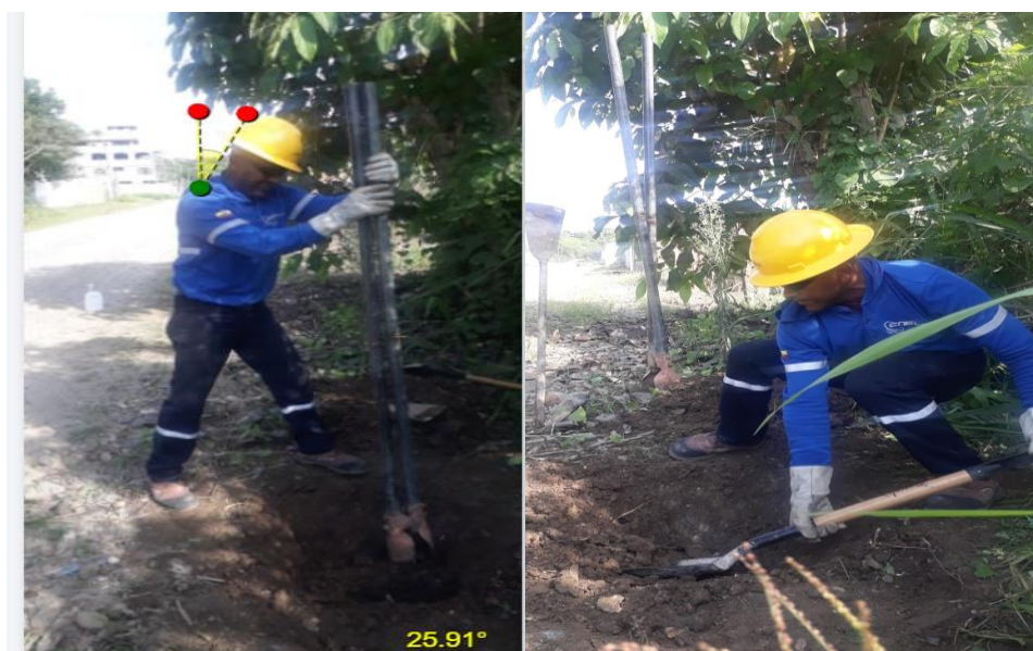
Figura 27. Levantamiento manual de carga-2 Fuente: Grupo excavadores de hoyos CNEL Unidad de Negocio Esmeraldas
