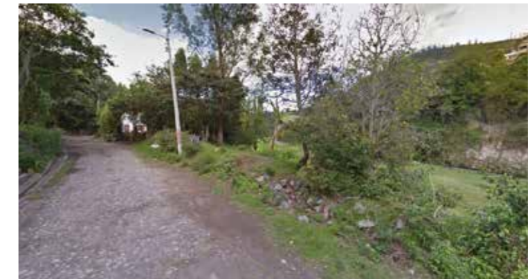
Ilustración 247: [Autores: Melissa Armas, Julián Bolaños] (Estado actual tramo N° 6, 2018)
