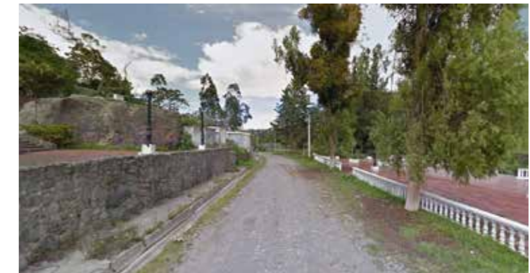
Ilustración 225: [Autores: Melissa Armas, Julián Bolaños] (Estado actual tramo N°4, 2018)
