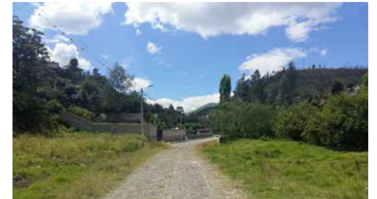
Ilustración 217: [Autores: Melissa Armas, Julián Bolaños] (Estado actual tramo N° 3, 2018)
