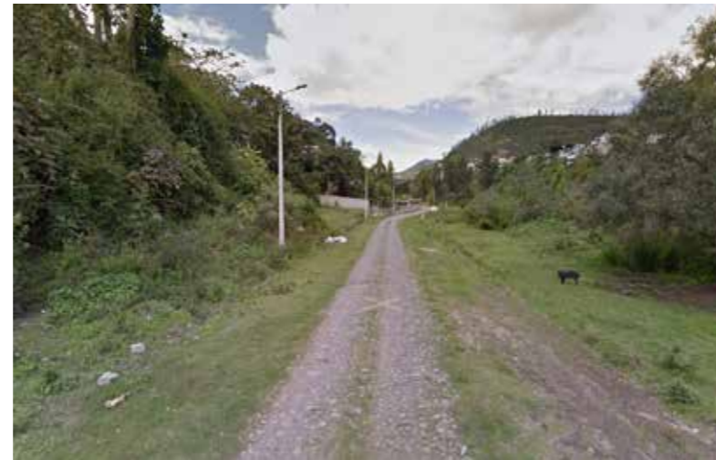
Ilustración 212: [Autores: Melissa Armas, Julián Bolaños] (Estado actual tramo N°2, 2018)
