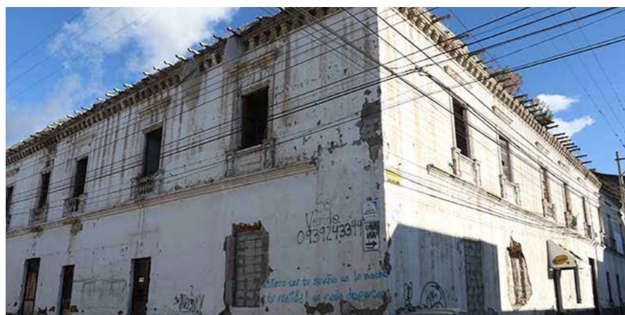
Ilustración 143: [Fotografía: Autor: Melissa Armas, Julián Bolaños] (Edificio abandonado, 2019)
