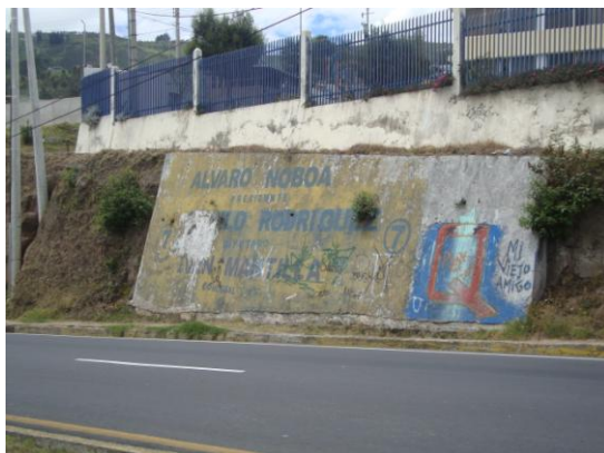
FIGURA 68 – Muros de Contención de la AGR
