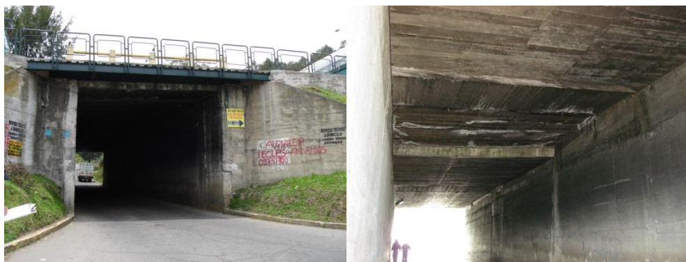
FIGURA 60 – Puente de Guangopolo
