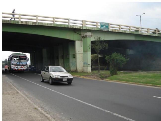
FIGURA 59 – Puente de la Avenida Simón Bolívar
