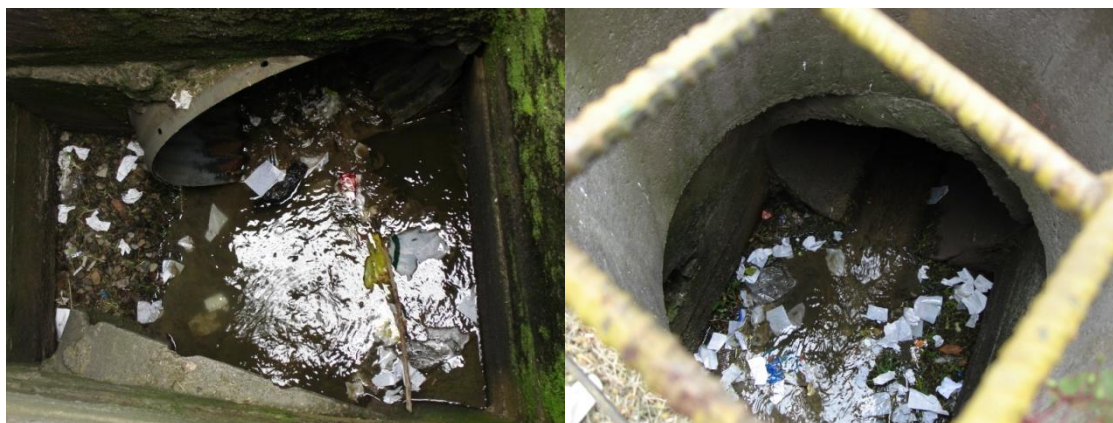
FIGURA 64 – Alcantarillas de la AGR
