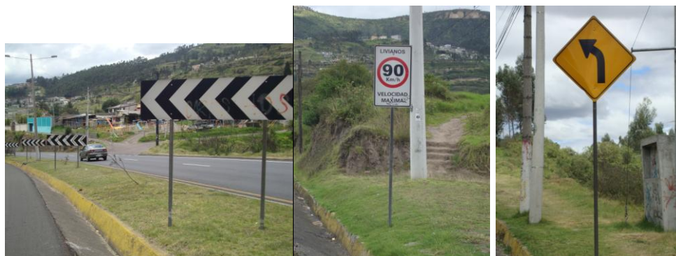
FIGURA 76 – Señalización Vertical en la AGR
