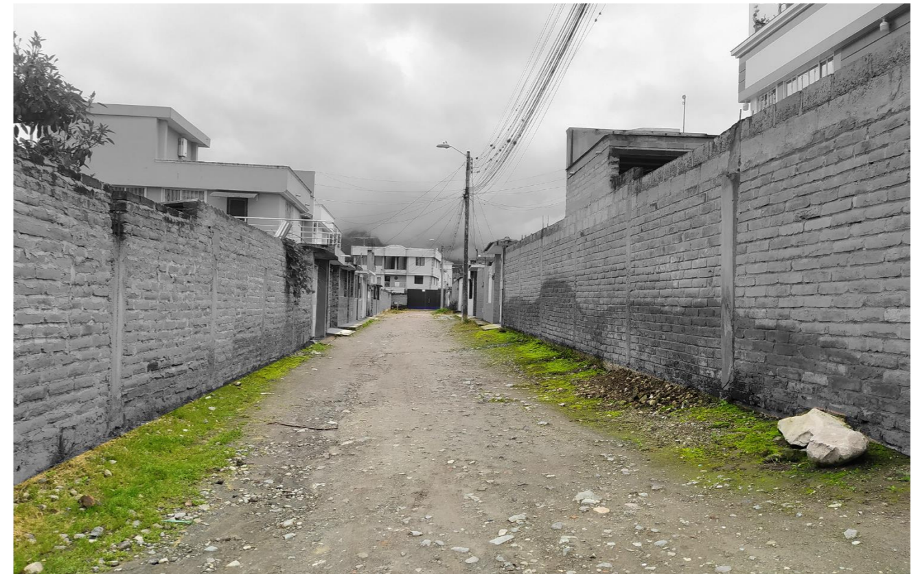
Figura 75: Estado actual de las vías
