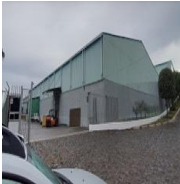
Figura 6. Infraestructura externa - bodega Schryver
