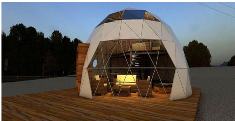
Figura 1. Eco domo Fuente: (Bionativos, 2016)
