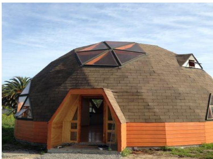
Figura 2. Eco domo Fuente: (Bionativos, 2016)
