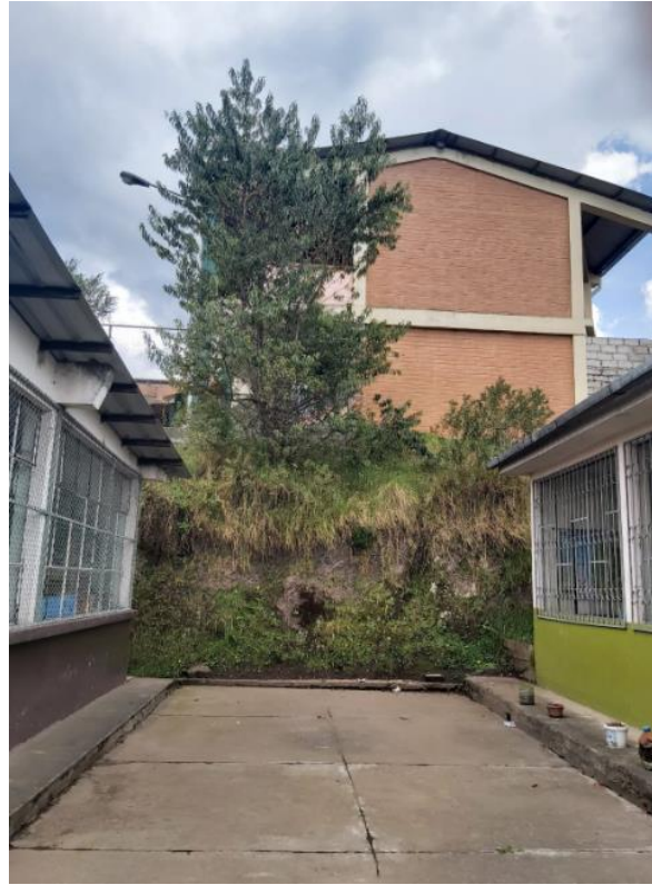
Ilustración 15. Talud bajo estructura EGB
