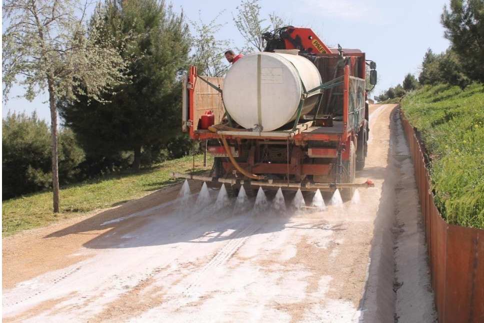
Ilustración 1.12. Mejoramiento Químico en Base. Fuente: www.agropeceingenieros.com
