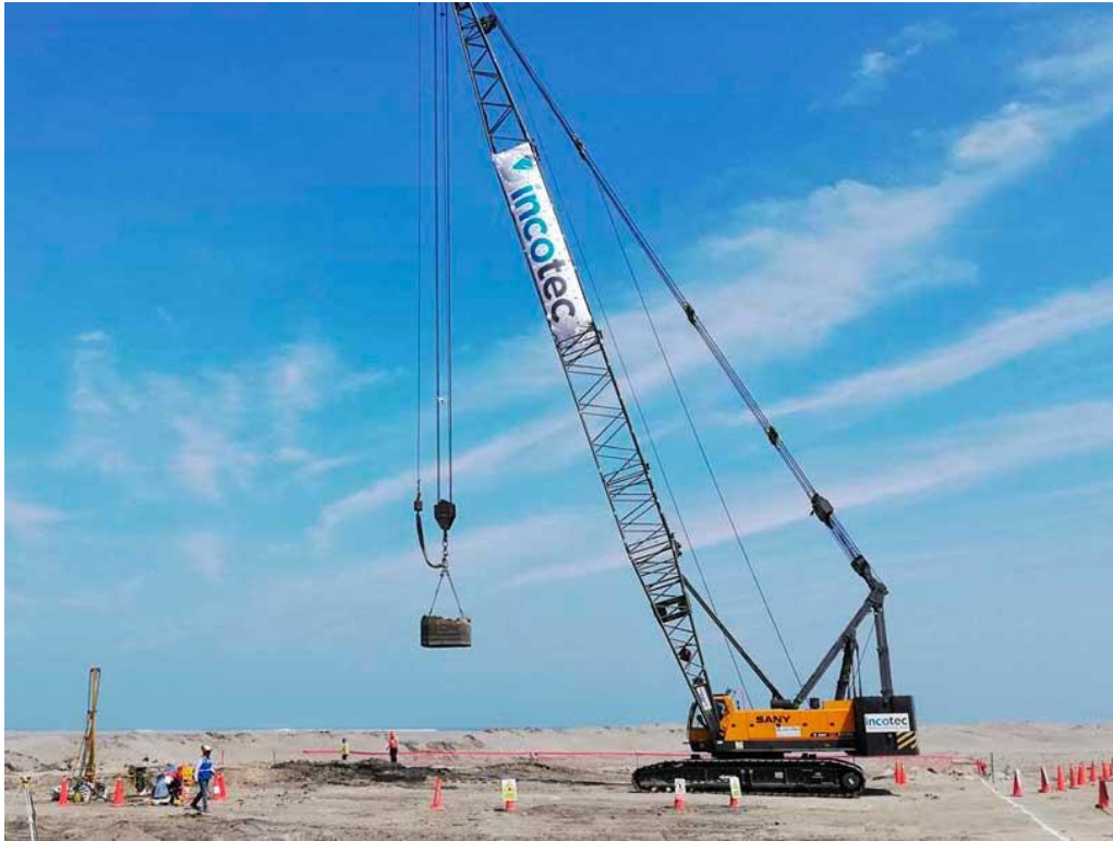
Ilustración 1.13. Compactación Dinámica. Fuente: www.incotecperu.pe
