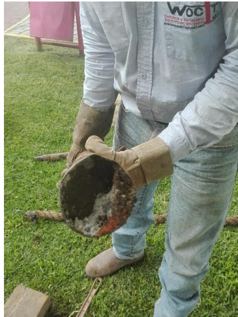
Figura N° 23: Presencia de materiales solidos (relleno/ladrillo).
