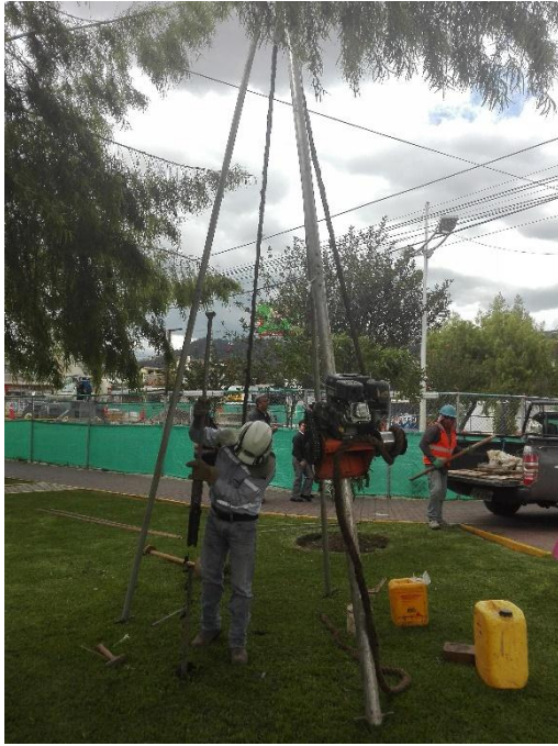
Figura N° 22: Proceso de extracción de muestras.
