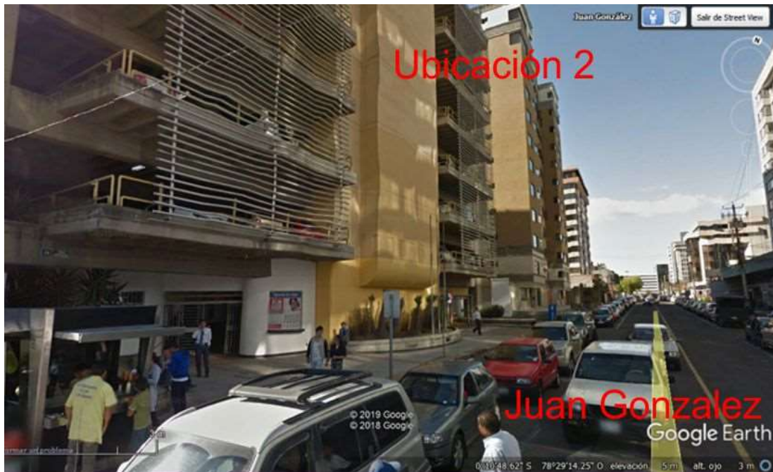
Figura 25. Vista en fachada de predio 2.
