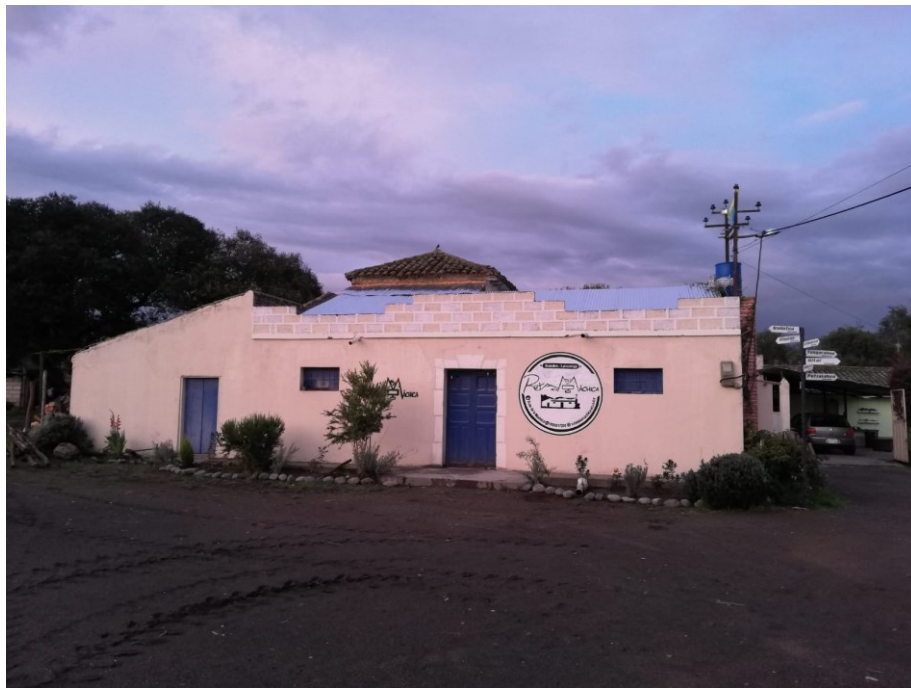
Figura 13. Fachada Ruta de la Máchica
