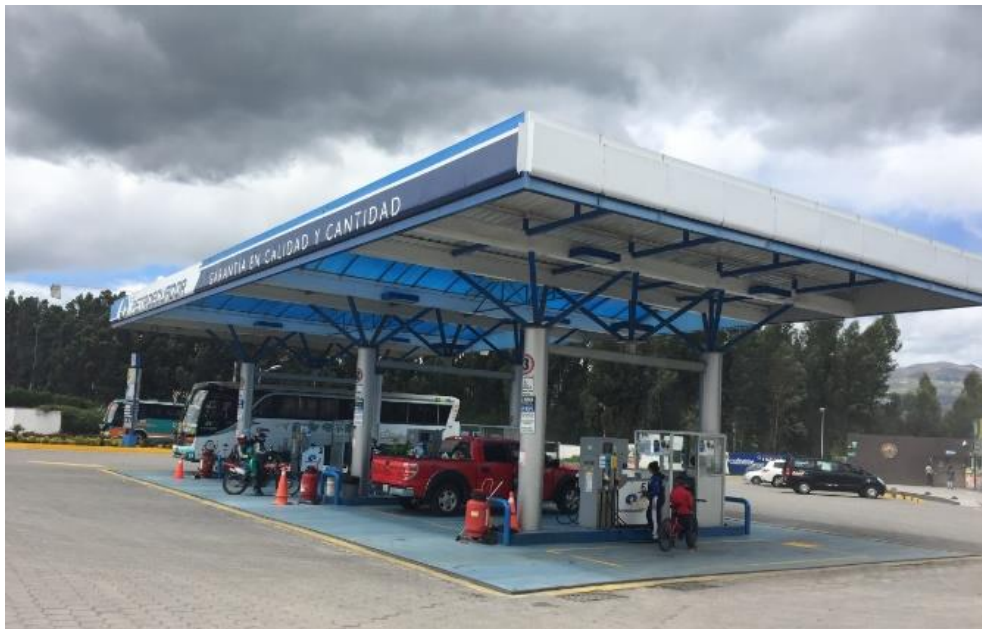
Fig 6. Gasolinera Petroecuador ubicada en Cayambe. Fuente: Levantamiento de Información en campo, 2017
