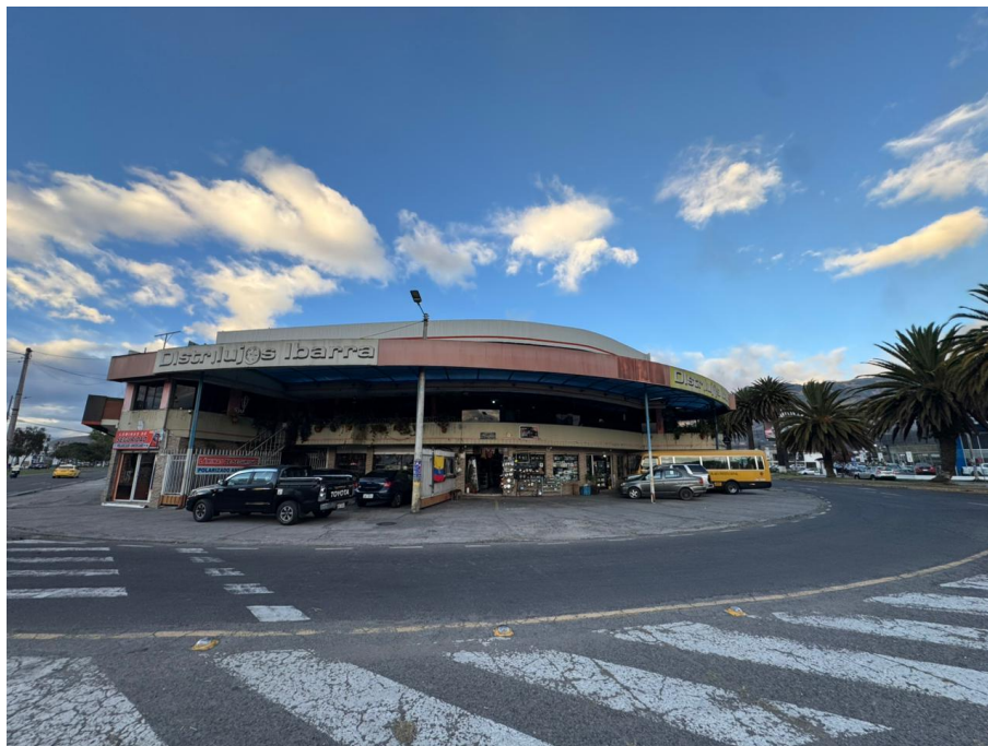
Ubicación del establecimiento: Av. Mariano Acosta 19-80 y Av. Cristóbal de Troya.
