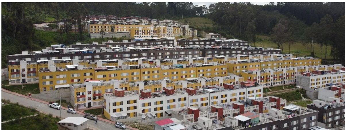
Figura 2. Urbanización Bellavista del Sur Segunda etapa. Elaborado por: Autor
