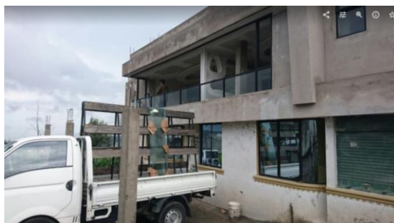
Figura 5 Instalación de estructuras
