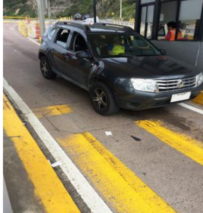
Imagen No. 4 Lazo de piso - Autoría Propia
