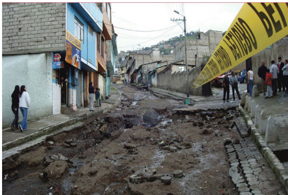
Vías en mal estado por flujo de lodo
