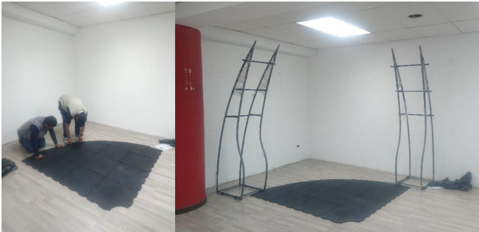
Figura 131. Instalación Piso Modular
