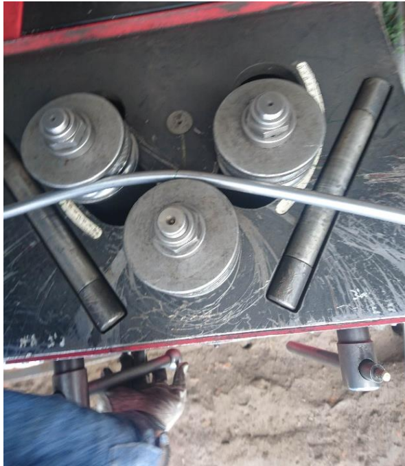
Figura 69. Barolado del corte de piezas. Fuente elaboración propia.
