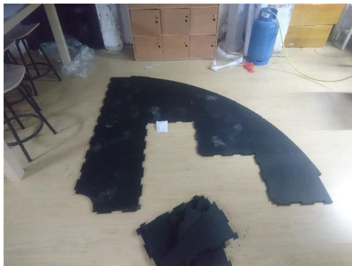
Figura 98. Piso modular Terminado. Fuente elaboración propia.
