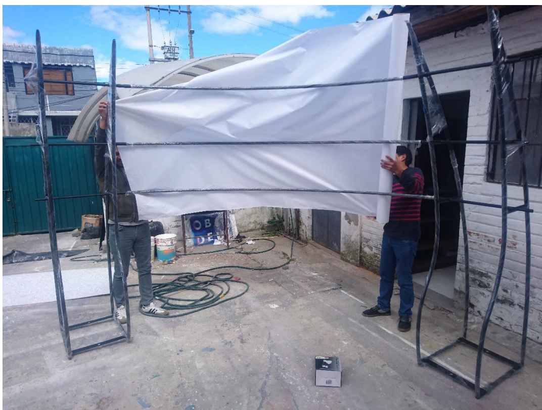
Figura 99. Intento de Recubrimiento con lona sobre cruces curvos. Fuente elaboración propia.
