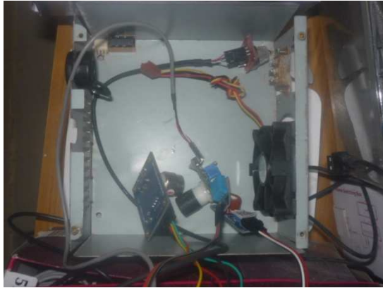
Figura 35: Elaboración de caja para Sensores de Gases Contaminantes
