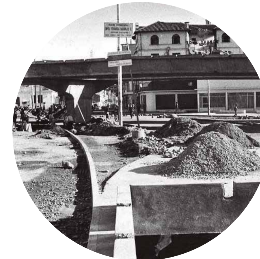
Puente del Guambra
