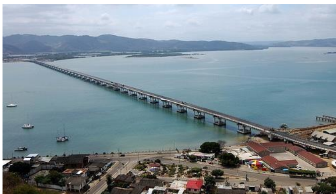
Figura 5 Puente los Caras. Fuente: (news, 2010)
