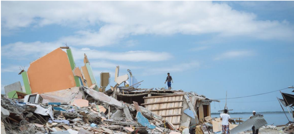
Figura 2 Terremoto en Ecuador. Fuente: (ONU, 2016).
