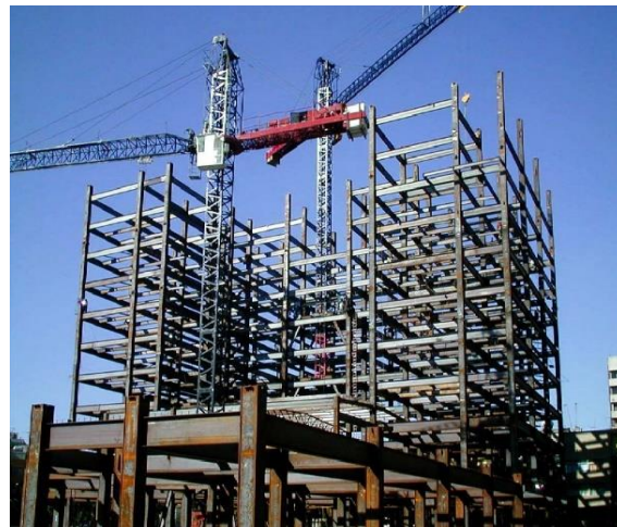
Figura 5: Estructura de acero
