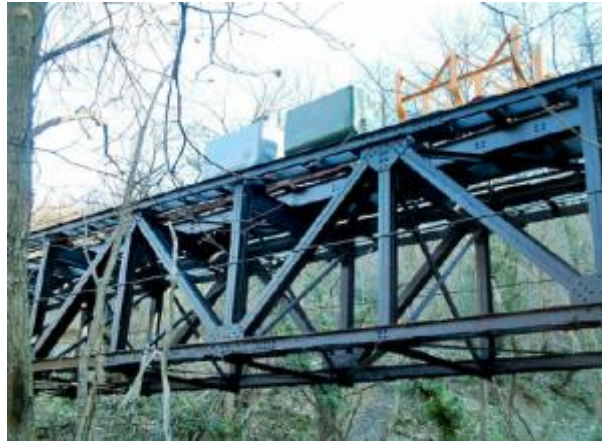
Figura 4: Puente de acero.
