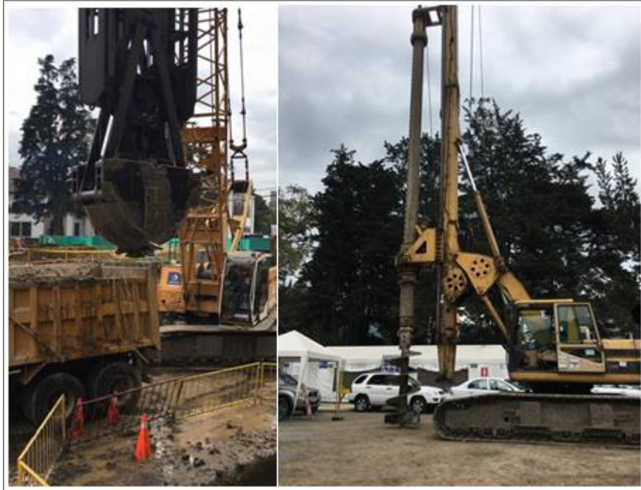
FIGURA 2.15 Maquinaria de excavación en Construcción Metro de Quito
