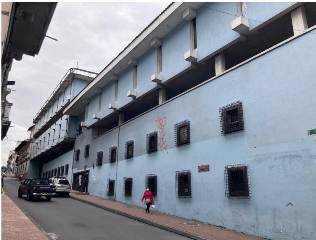
Figura 15. Fachada calle Vargas del Centro comercial Gran Pasaje. Elaboración propia 2022.
